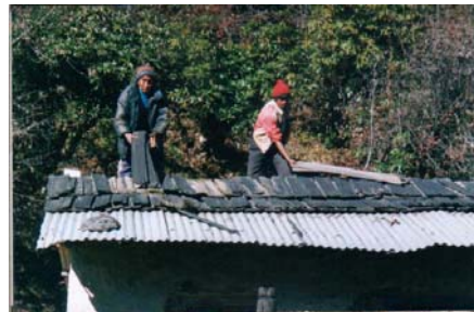
Travaux Kyama (nov 04)
